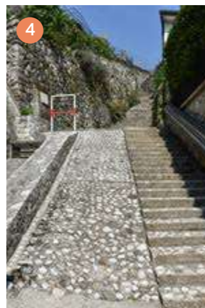
4 Dettaglio delle pavimentazioni e scolo acque
