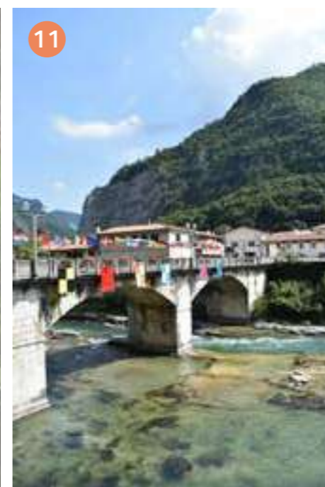
11 Ponte pedonale e veicolare
